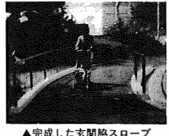
▲完成した玄関脇スロープ
