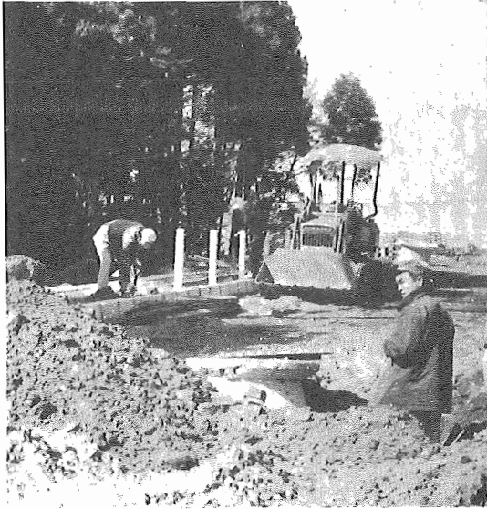
ブルドオザアの音も力強く道路の舗装は進む
