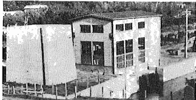
小堀排水機場完成 昭和三十九年から小堀地先に新設中の小堀排水機場(容量)が完成し、六月十日に関係者が多数出席して通水式が行なわれました。
