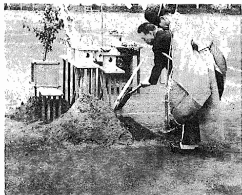
写真…我孫子中学校体育館起工式
