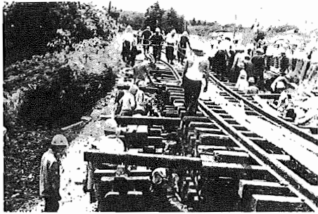
写真…成田線の復旧工事
