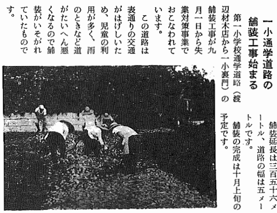
一小通学道路の舗装工事始まる 第一小学校通学道路(渡辺材木店から一小裏門)の舗装の完成は十月上旬の予定です。
