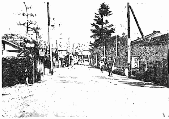
(二期舗装工事の完成した公園通り)
