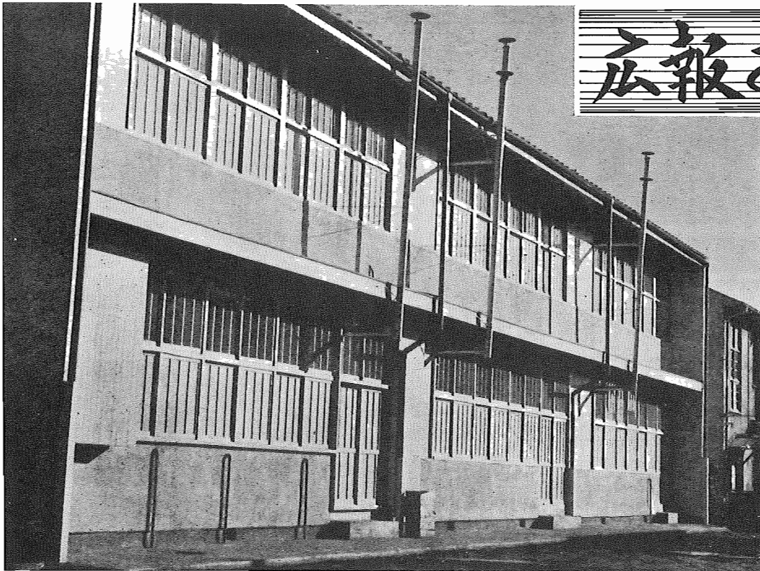
我孫子中学校の新校舎完成
