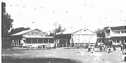
(湖北小学校増築現場) 坪数 95坪 工事費 249万円
