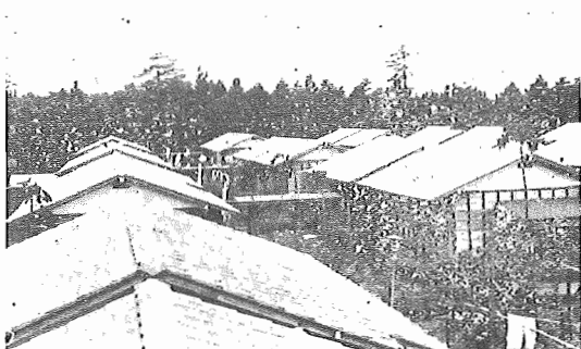
(町営住宅の建設)
