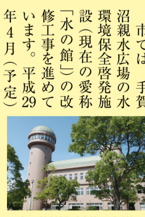
▲水の館外観(改修工事前)
