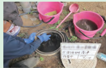
▲雨水桝の除染作業
