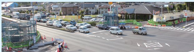
▲歩道橋工事の状況(7月2日時点)
