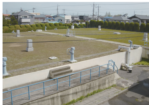
▲平成25・26年度実施 湖北台浄水場配水池
