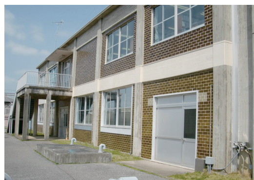
▲平成25年度実施 湖北台浄水場管理棟
