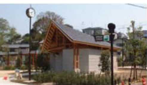
▲トイレ、ソーラー式時計と誘導灯
