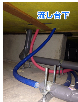
ヘッダー廻りの給水配管 [床下騒音発生現場 (竣工後3年)]
