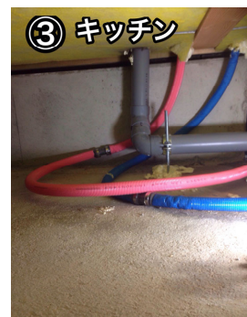
ヘッダー廻りの給水配管 [床下騒音発生現場 (竣工後3年)]
