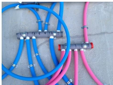
ヘッダー廻りの給水配管 [床下騒音発生現場 (竣工後3年)]
