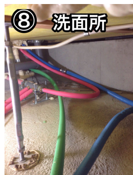
ヘッダー廻りの給水配管 [床下騒音発生現場 (竣工後3年)]
