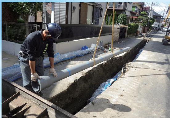
▲水道管更新(ダクタイトル鉄製)
