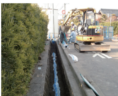
▲高機能ダクタイル鉄管埋設状況
