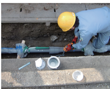
▲高機能ダクタイル鉄管接合状況
