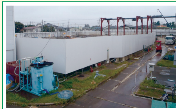
湖北台浄水場(配水池)
