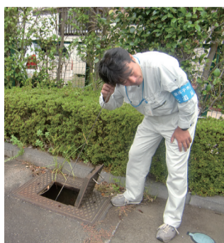
▲漏水調査をしている様子
