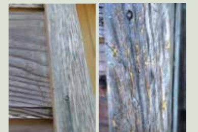
屋根裏に棲みつき、頻りに登り降りすることでできた爪跡の傷
