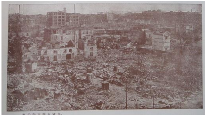
↑丸の内の被害状況（一面が焼け野原）
