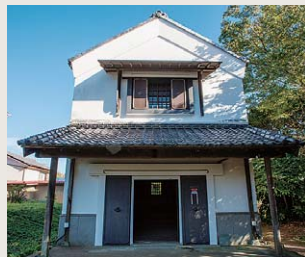
昭和初期新建的仓库。为了应对洪水灾害，修建在略高于地面的地基上。
