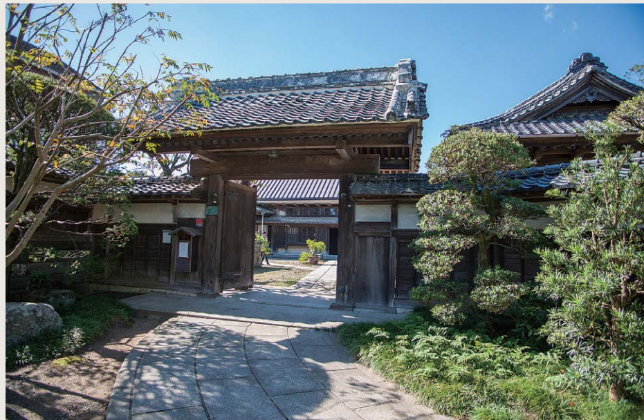
正门是真正的江户末年“药医门”。其特点是，由2根支柱和后方的2根辅助立柱支撑着双坡屋顶。
