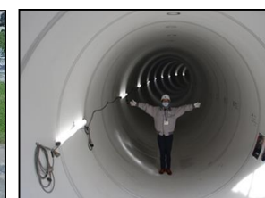
整備後の状況(管路内部)
