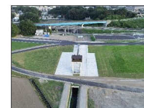
後田樋管(整備後)
