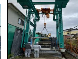
雨水幹線施工状況
