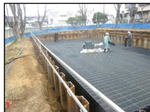
暫定貯留浸透施設(施工時)
