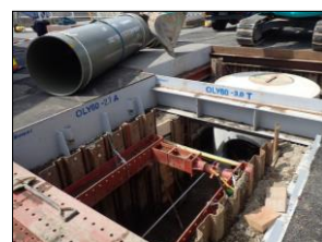
雨水管布設工事
