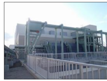
布佐ポンプ場完成
