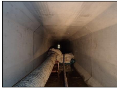
雨水管内部状況（工事中）
