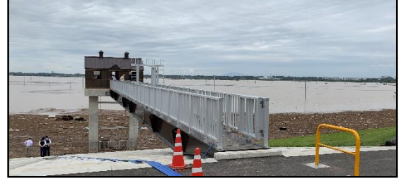
後田樋管堤防天端からの田中調節池湛水状況
