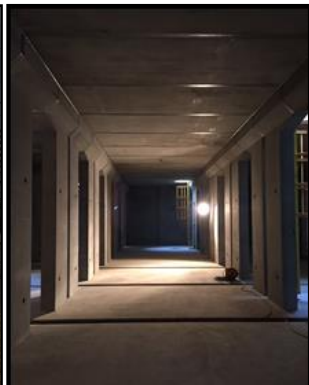
地下式調整池内部
