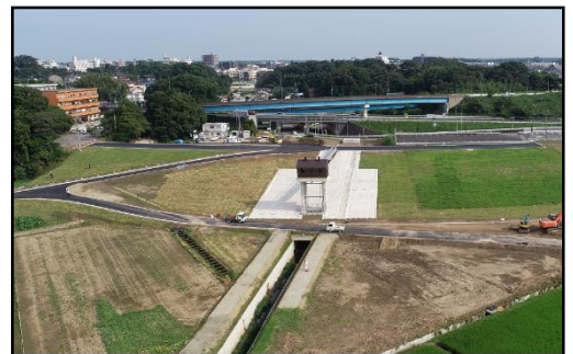
後田樋管施工状況（R元.7月）
