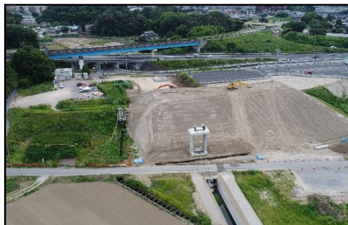
後田樋管施工状況（H30.7月）
