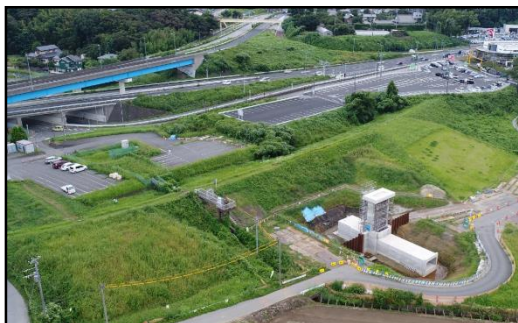
後田樋管施工状況（H29.8月）
