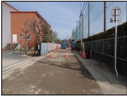
管布設後の仮復旧状況
